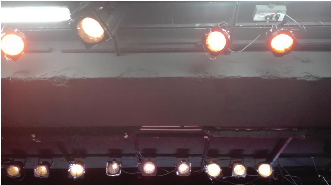
Dos estructuras de Truss triangular motorizadas de 3m situadas encima de platea, accionables desde hombro derecho:
